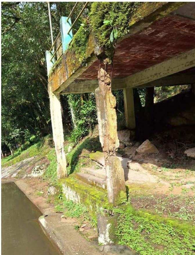
Foto dos pilares a serem reforçados
