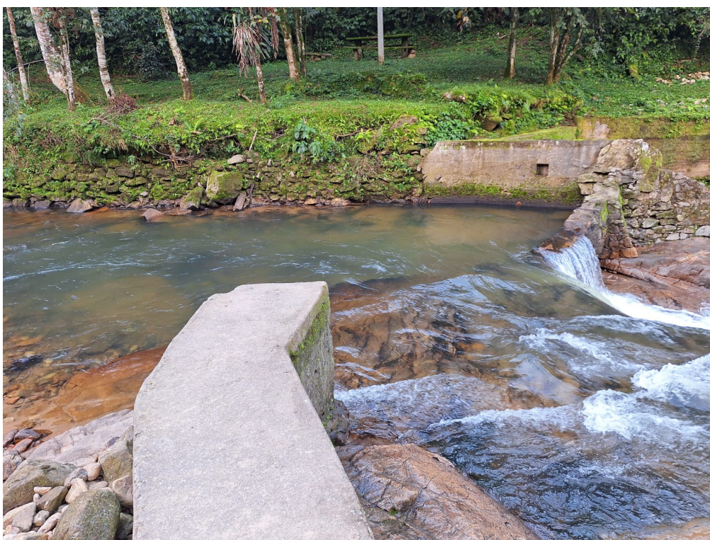
Foto do local da contenção a ser realizada.
