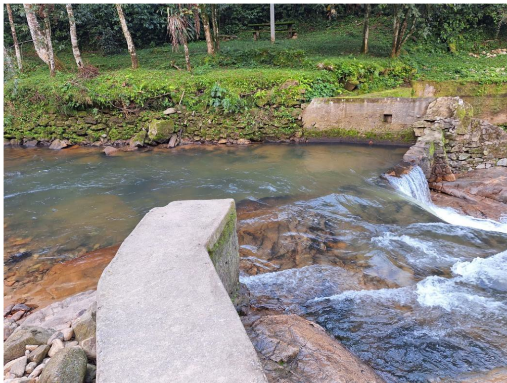
Foto do local da contenção a ser realizada.
