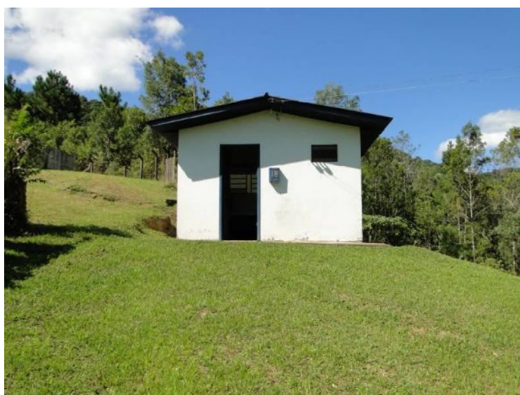
Figura 4 - Casa de química desativada. Fonte: Visita Técnica STE, 2010.
