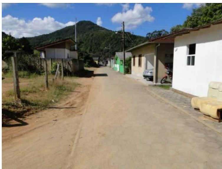
Figura 28 - Ponto de alagamento 02. Fonte: Visita Técnica STE, 2010.
