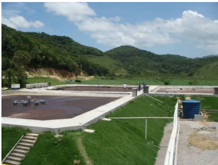
Figura 20 - Sistema de tratamento de líquidos percolados. Fonte: ProActiva, 2010.
