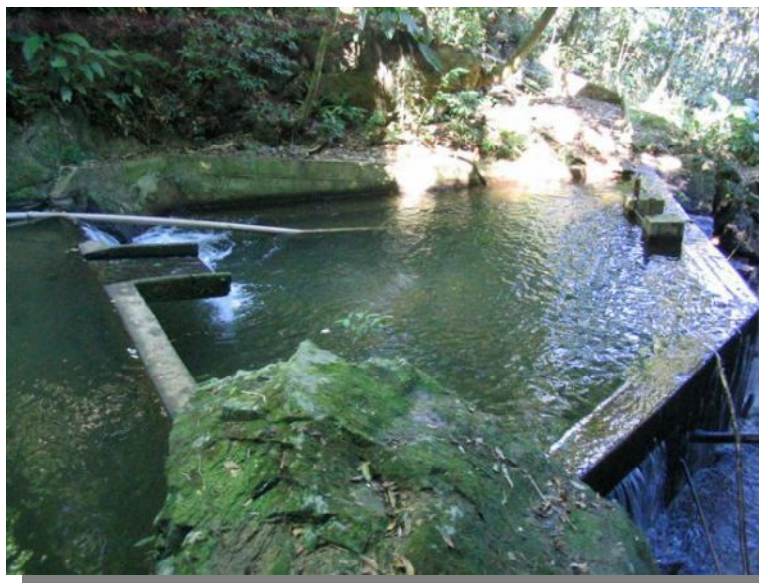
Figura 2 - Captação de água bruta - barragem de nível em concreto armado. Fonte: SANETAL, 2006.
