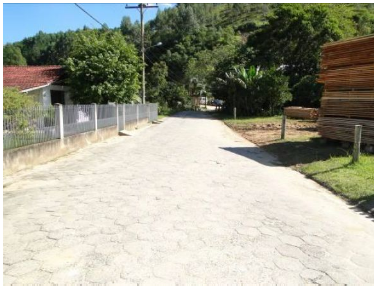
Figura 27 - Ponto de alagamento 01. Fonte: Visita Técnica STE, 2010.
