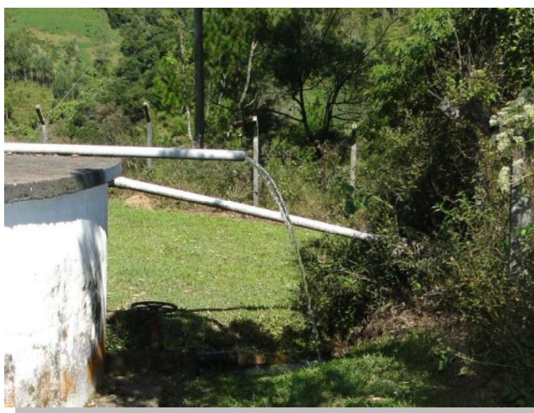
Figura 5 - Reservatório de água. Fonte: Visita Técnica STE, 2010.
