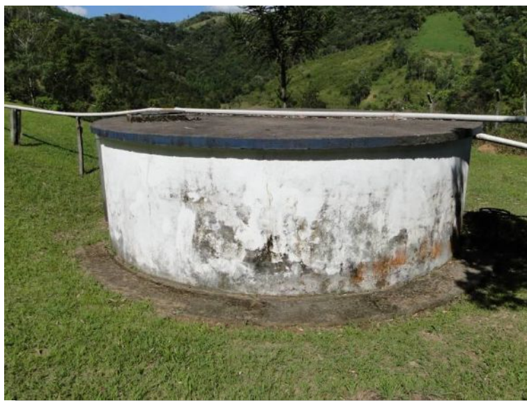
Figura 6 - Reservatório de água. Fonte: Visita Técnica STE, 2010.
