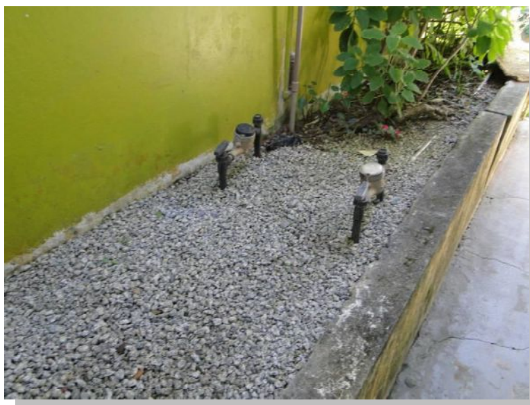
Figura 7 - Micro-medidor residencial com Hidrômetro – rede de abastecimento. Fonte: Visita Técnica STE, 2010.
